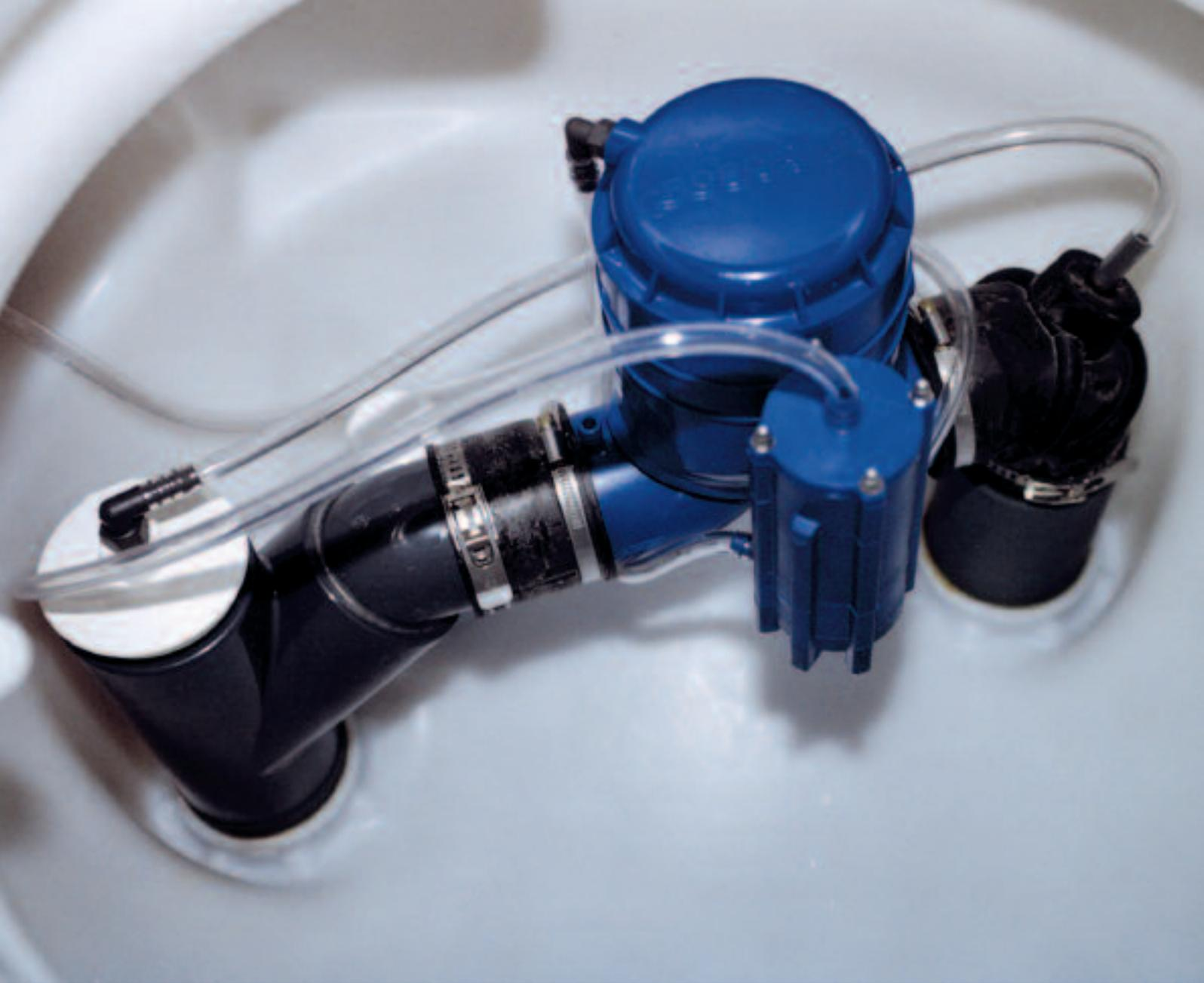
Arriba: Válvula de vacío RoeVac® de 65 mm de diámetro tipo diafragma incluyendo la unidad controladora neumática (cilindro al frente) y la tapa del sensor de
