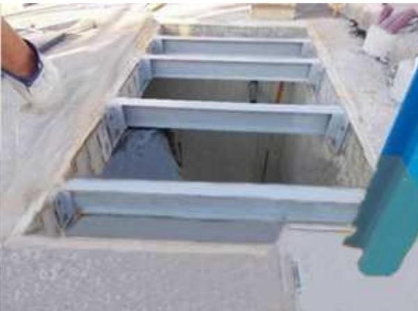
Estas vigas son extraíbles, lo que permite introducir o extraer cualquier equipo para a continuación volver a colocar las vigas y cerrar las tapaderas.
