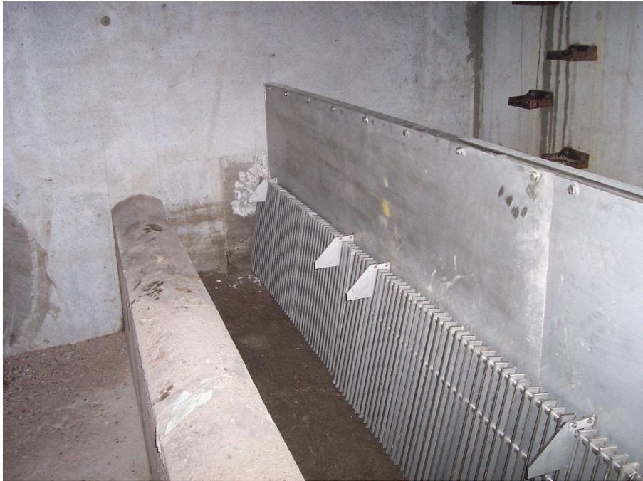
Aliviadero con retención de flotantes y sólidos constituido por un fluidRack colocado sobre una pantalla anti-flotantes de acero inoxidable.
