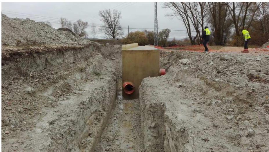
Aliviadero colocado en obra
