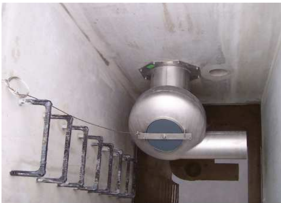
Válvula reguladora vórtex cónica, modelo Clean Water-UFT FluidCon-n de 45 grados de inclinación.
