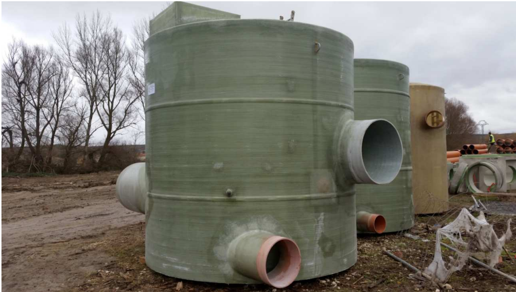
Varios aliviaderos en obra listos para ser instalados
