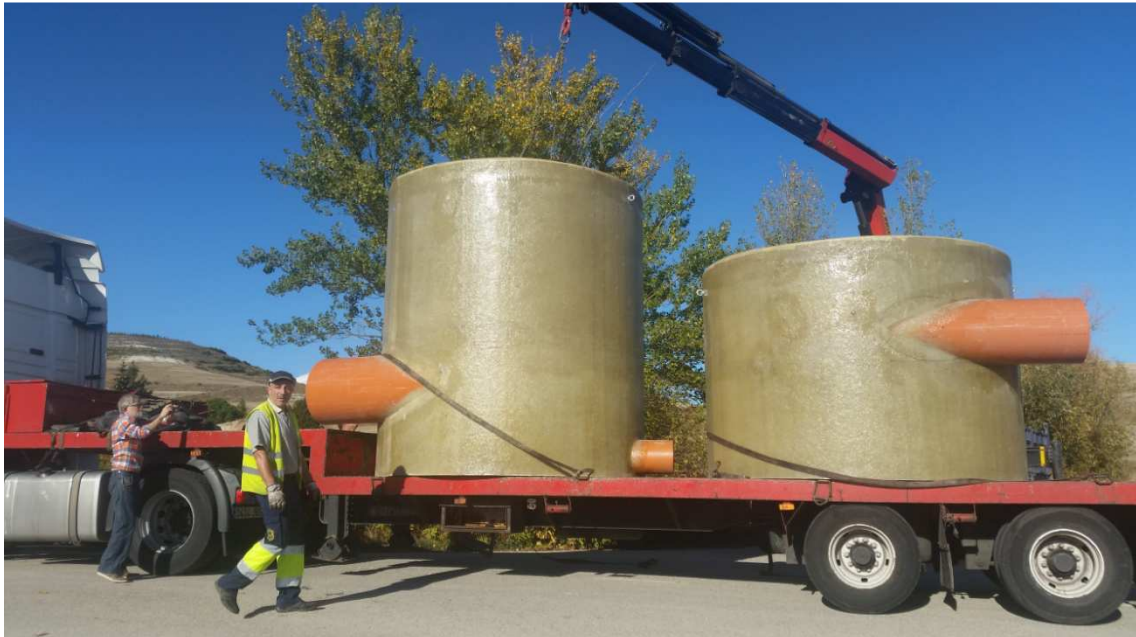
Llegada a obra de dos aliviaderos prefabricados
