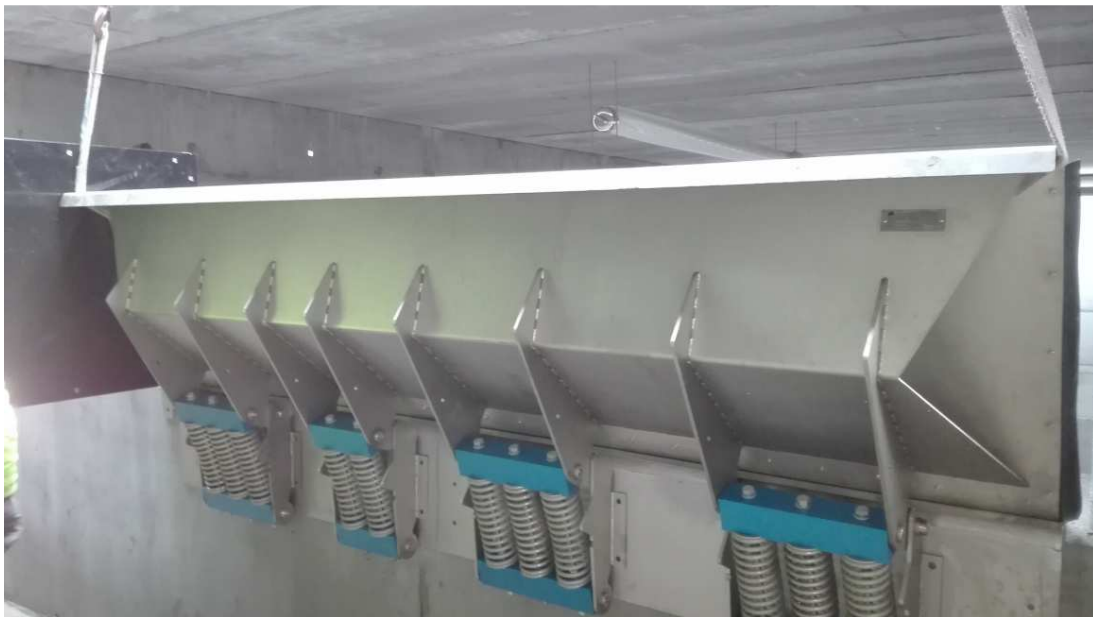
Uno de los flaps colocados, a falta de fijarlos al muro con “spits”
